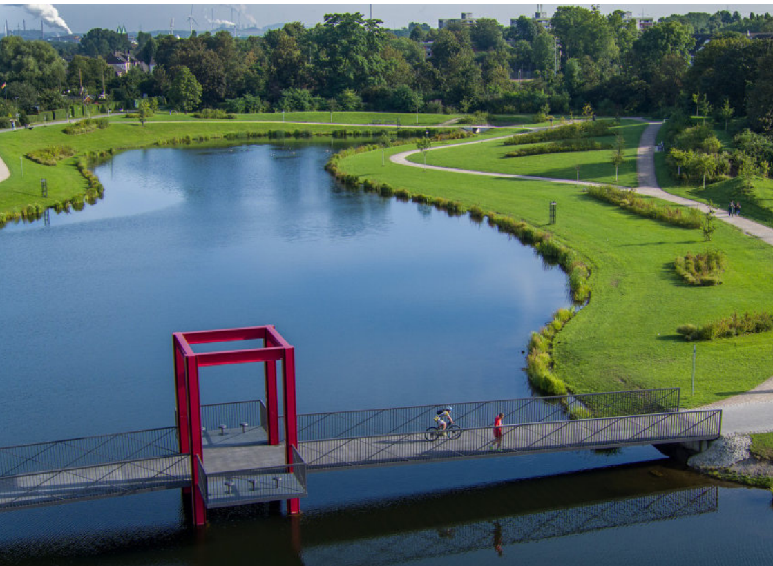
Brücke im Verlauf des RS1 über den Niederfeldsee in Essen
