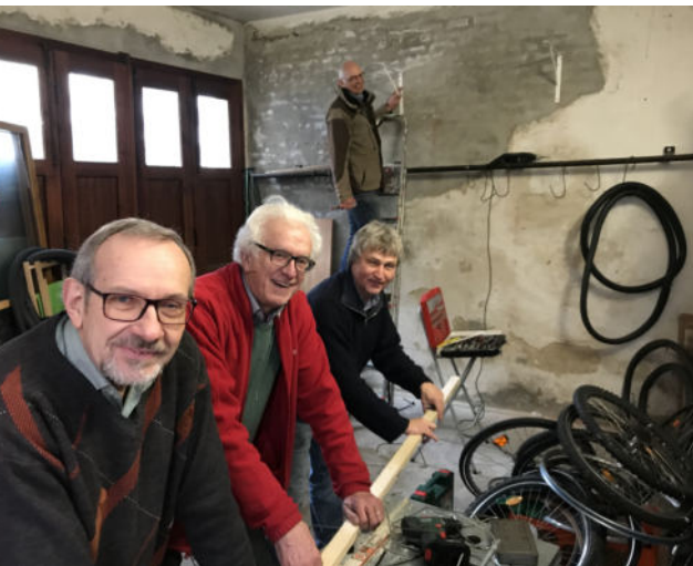
Umbau der Werkstatt
